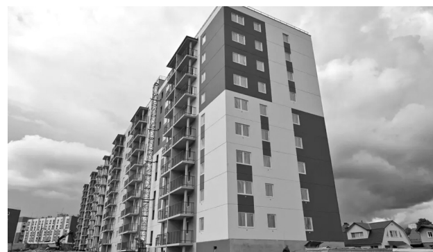
Дом под расселение на улице Белинского в Петрозаводске в июне 2026 года
