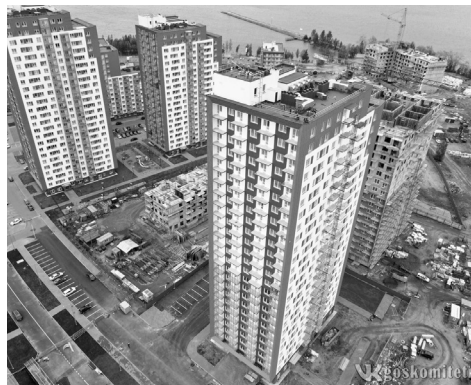
В Петрозаводске Госстройнадзор проверил ход строительства 25-этажного жилого дома в районе Соломенского шоссе и улицы Зайцева.
