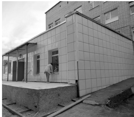
Подрядчик зашил фасад холла терапевтического корпуса. Сейчас заканчивает приводить в порядок душевые, укладывает тротуарную плитку на отмостку.
