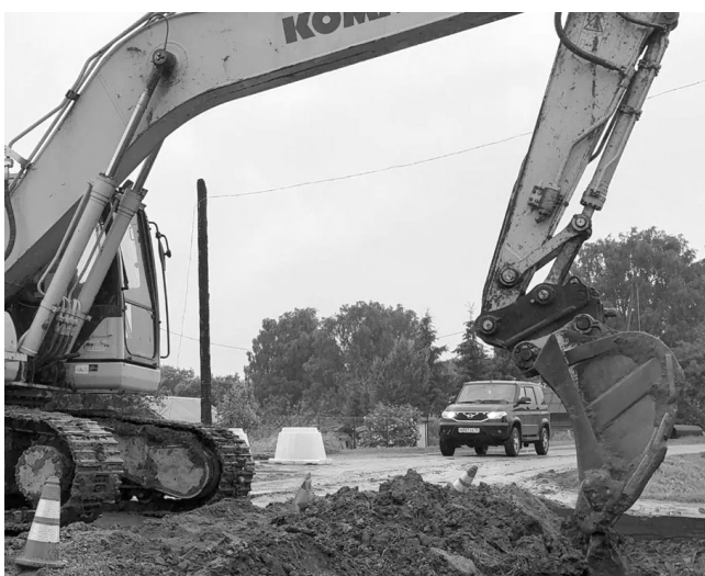
Специалисты начали фрезеровать старое асфальтобетонное покрытие. Далее предстоит ремонт покрытия проезжей части, обустройство освещения, автобусных остановок.
