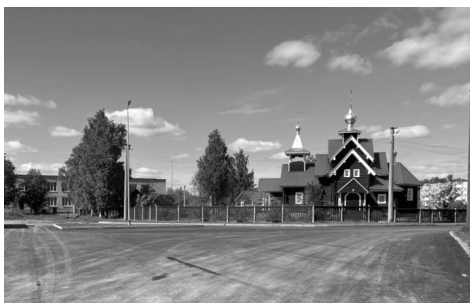
В селе Янишполе Кондопожского района благоустроили главную площадь. Работы провели в рамках госпрограммы «Комплексное развитие сельских территорий». Затра-
