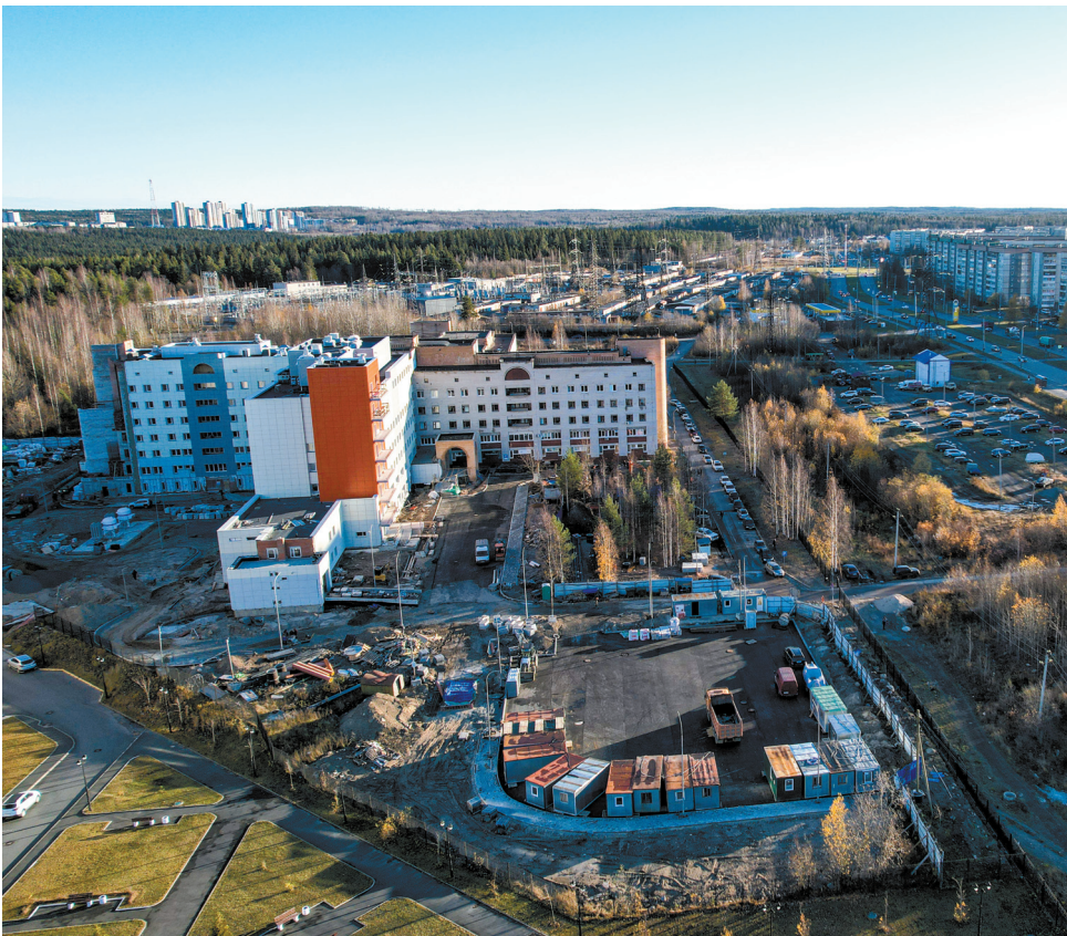
Блоки А и Б межрайонной больницы
