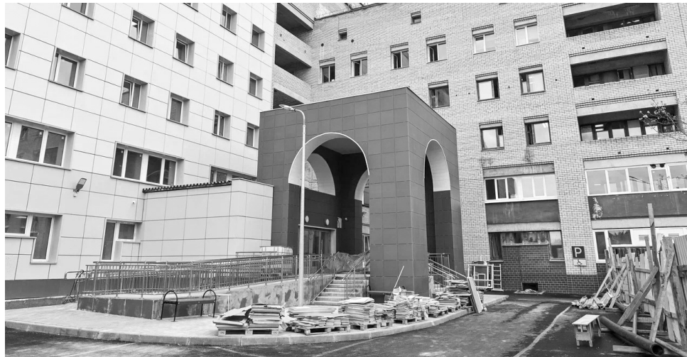
Блоки А и Б межрайонной больницы
