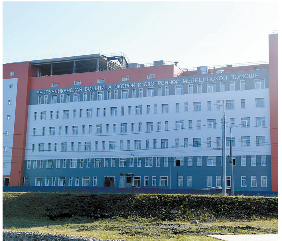
Хирургический корпус в Петрозаводске
