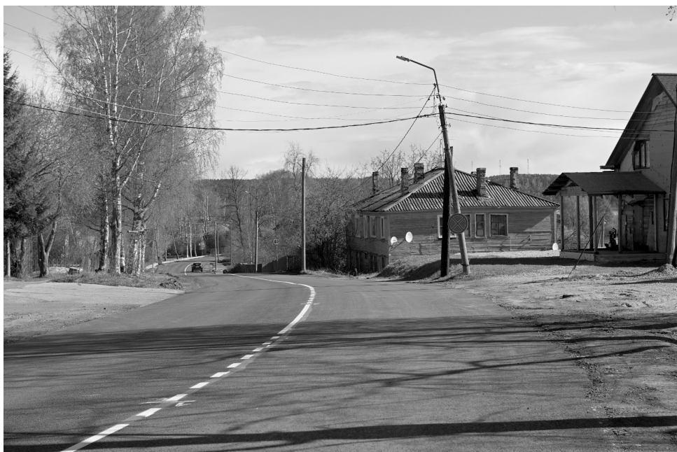
Дороги в Пряже
