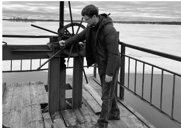
Проверка ремонтного затвора
