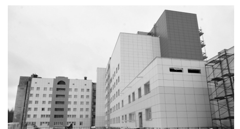
Корпуса на Древянке
